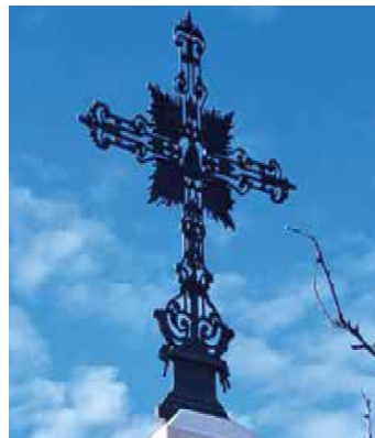
Après la restauration
