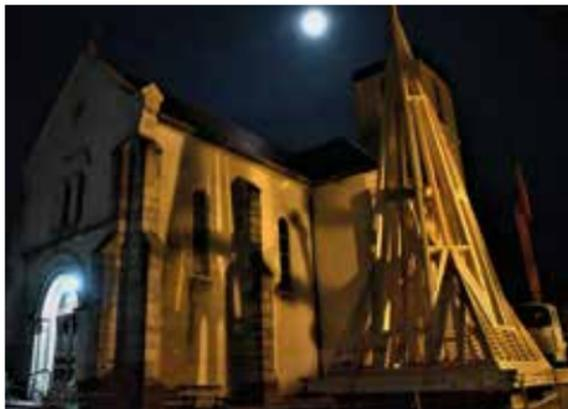
Après quelques procédures administratives et l'approbation du Conseil municipal, c'est Manuel Ferreira, charpentier installé dans le village, qui a pu construire l'ossature du clocher avant que soient disposées les ardoises et que le zingueur achève ce travail. Cette construction au sol aura permis à tous d'en voir les étapes et aux enfants de l'école primaire voisine de découvrir le métier de charpentier.
